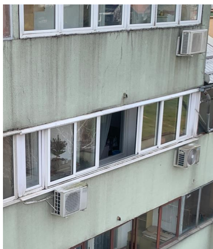
Slika 2-37 Vanjske jedinice SPLIT sustava
