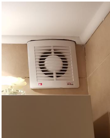
Slika 2-39 Odsisni ventilator
