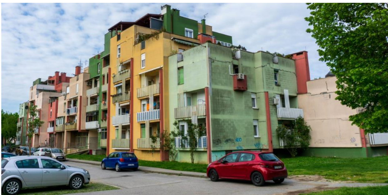
Slika 2-1 Predmetna stambeno poslovna zgrada Bolnička cesta 94, 96, Zagreb
